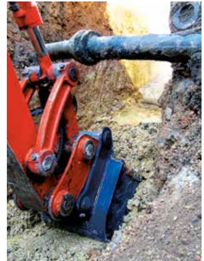
... und gut befüllt trotz Hindernis
